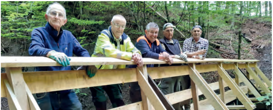
Meine stolzen Kollegen mit der fertigen Brücke beim Lochbach hinter Matug
